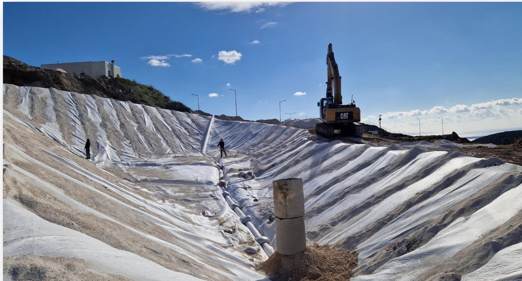
Κατασκευή Κυττάρου ΧΥΤΑ ως πρώτη ενδιάμεση λύση
