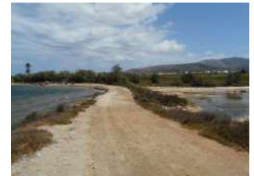
Άποψη από τον δρόμο, που διακόπτει την επαφή υγρότοπου-θάλασσας.
