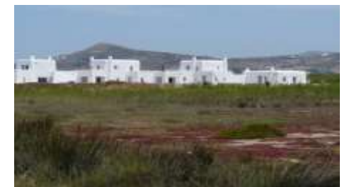
Νεόχτιστες μεζονέτες στα όρια του υγρότοπου.
